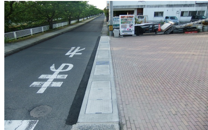
8. 型枠を取り外し蓋を掛け、周囲を復旧すれば新設の側溝と変わらない できばえになります。
