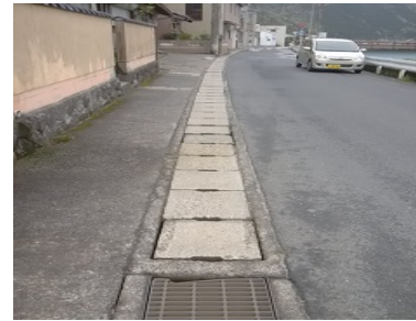
智頭町：町道本折南方線側溝修繕工事 車両の通過によるガタツキ音がなくなりました。
