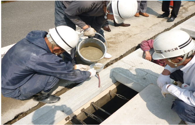
5. モルタル注入孔より高流動性無収縮モルタルを注入します。
