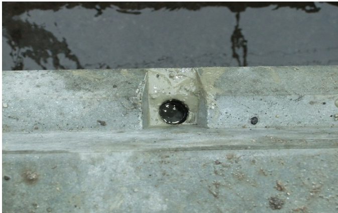
6. モルタル注入孔にモルタルが盛り上がってくれば注入完了です。
